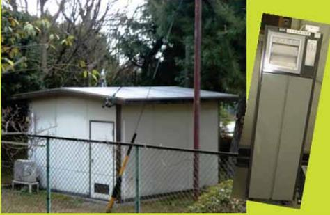
大気汚染公害を受け、四日市市内の各所に、大気環境測定局を設置しました。現在は、市内 11 か所に測定局があり（三重県内の他の市では、1～3 か所）、1 時間ごとに大気汚染物質の濃度を自動で測定しています。その結果は、市のホームページで確認することができます。
